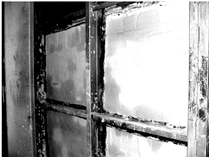
Рисунок 1 – Монтаж обмуровки котлоагрегата Сургутской ГРЭС-1
