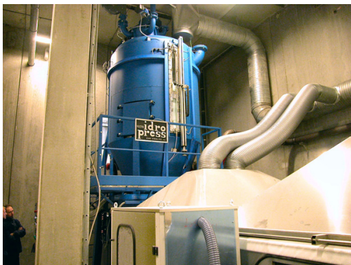
Рисунок 4 – Местная вытяжная вентиляция в модельном цехе
