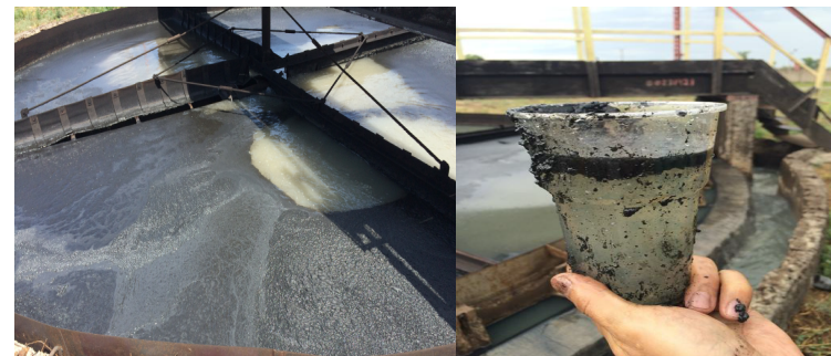
Рисунок 5 – Внешний вид пены флотатора. Видно, что вода хорошо отделяется. Пена собирается в хлопья
