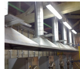
Рисунок 2 – Вытяжная вентиляция в модельном цехе
