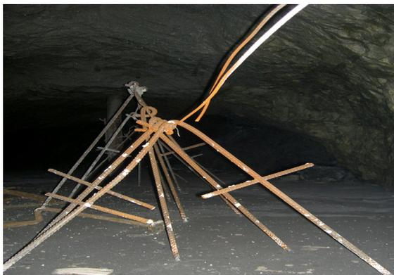
б) вид армировки после укладки несущего слоя.
