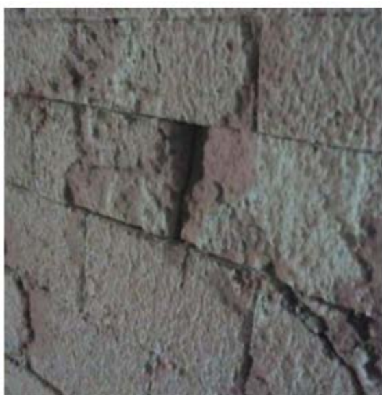
Рис. 1. Состояние футеровки зоны кальцинации
