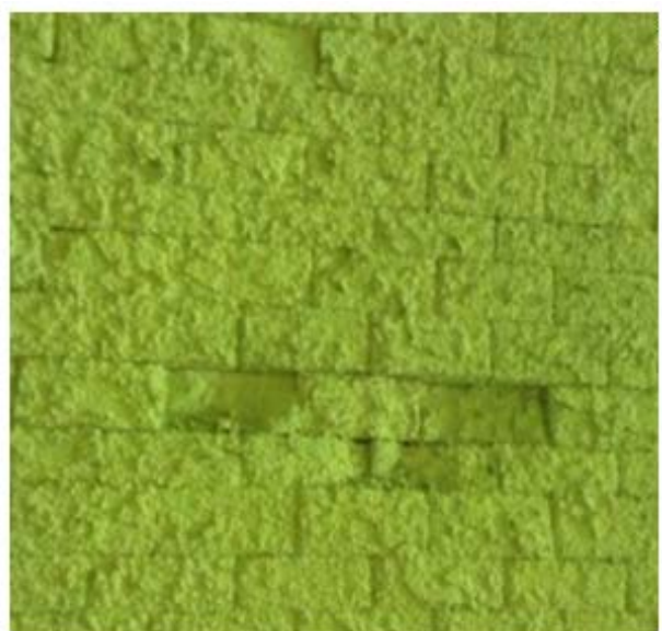
Рис. 1. Состояние футеровки зоны кальцинации
