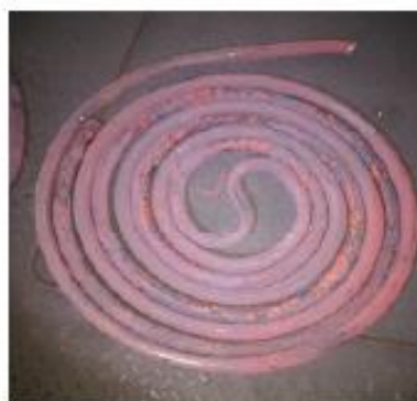
Рисунок 2 – Наружная поверхность труб змеевиков
