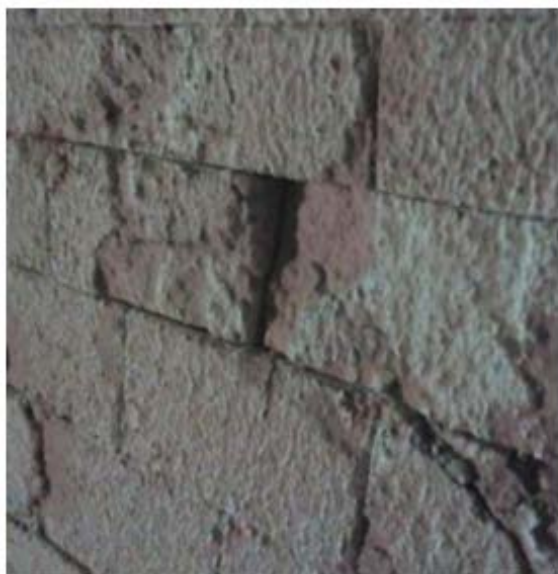
Рис. 1. Состояние футеровки зоны кальцинации
