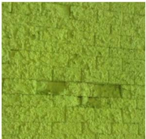
Рис. 1. Состояние футеровки зоны кальцинации
