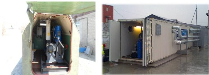
Рисунок 3 – Общий вид блочно-модульных теплонасосных установок (БМТУ)
