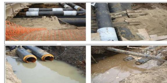
Рисунок 2 – Затопленные теплотрассы
